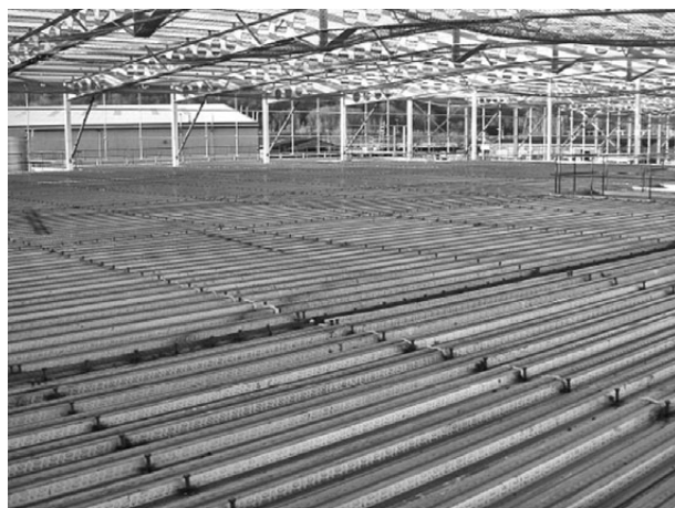
1 pav. Kompozitinės plieninės-betoninės plokštės prieš betonuojant (lakštiniai profiliuočiai sumontuoti ant metalinio sijyno)
