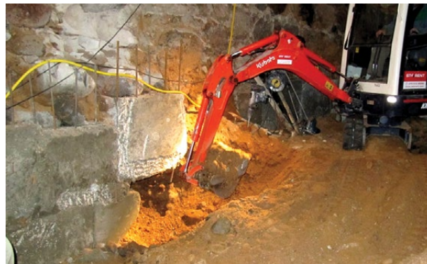
6 pav. Iškasų po pamatų įrengimas naudojant mechanizmus
