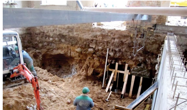
11 pav. Pamatų gilinimas srautinio injektavimo būdu ir įrengiant iškasas
