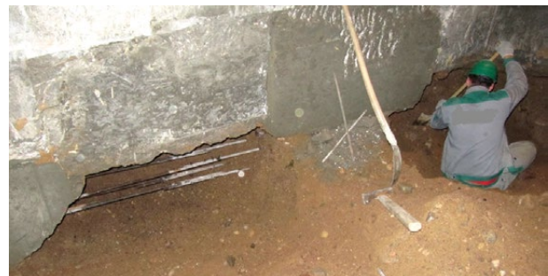
4 pav. Iškasų po pamatų įrengimas rankiniu būdu
