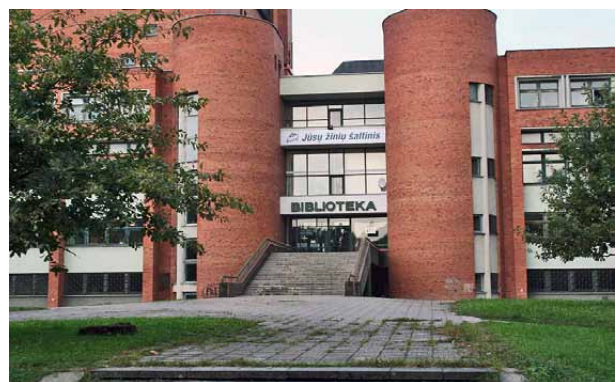
1 pav. Kauno apskrities viešosios bibliotekos pagrindinė įeiga Fig. 1. Main entrance of the Kaunas County Public Library
