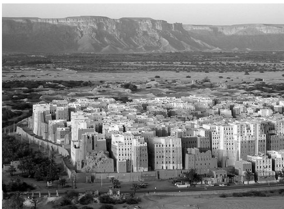
2 pav. Tankiai apstatytas daugiaaukščiais pastatais Shibam miestas Jemene
